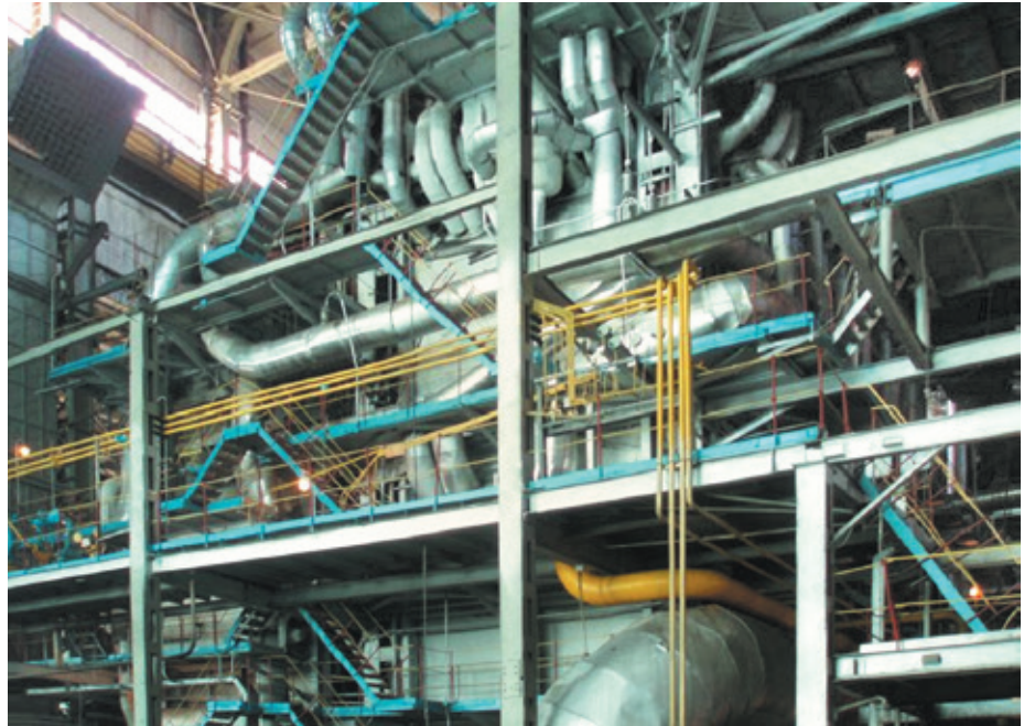
Рис. 2. Паровой котел БКЗ-320-140/ГМ
