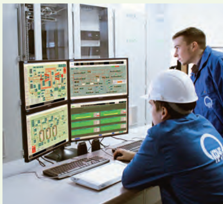
Тестирование системы на полигоне компании
